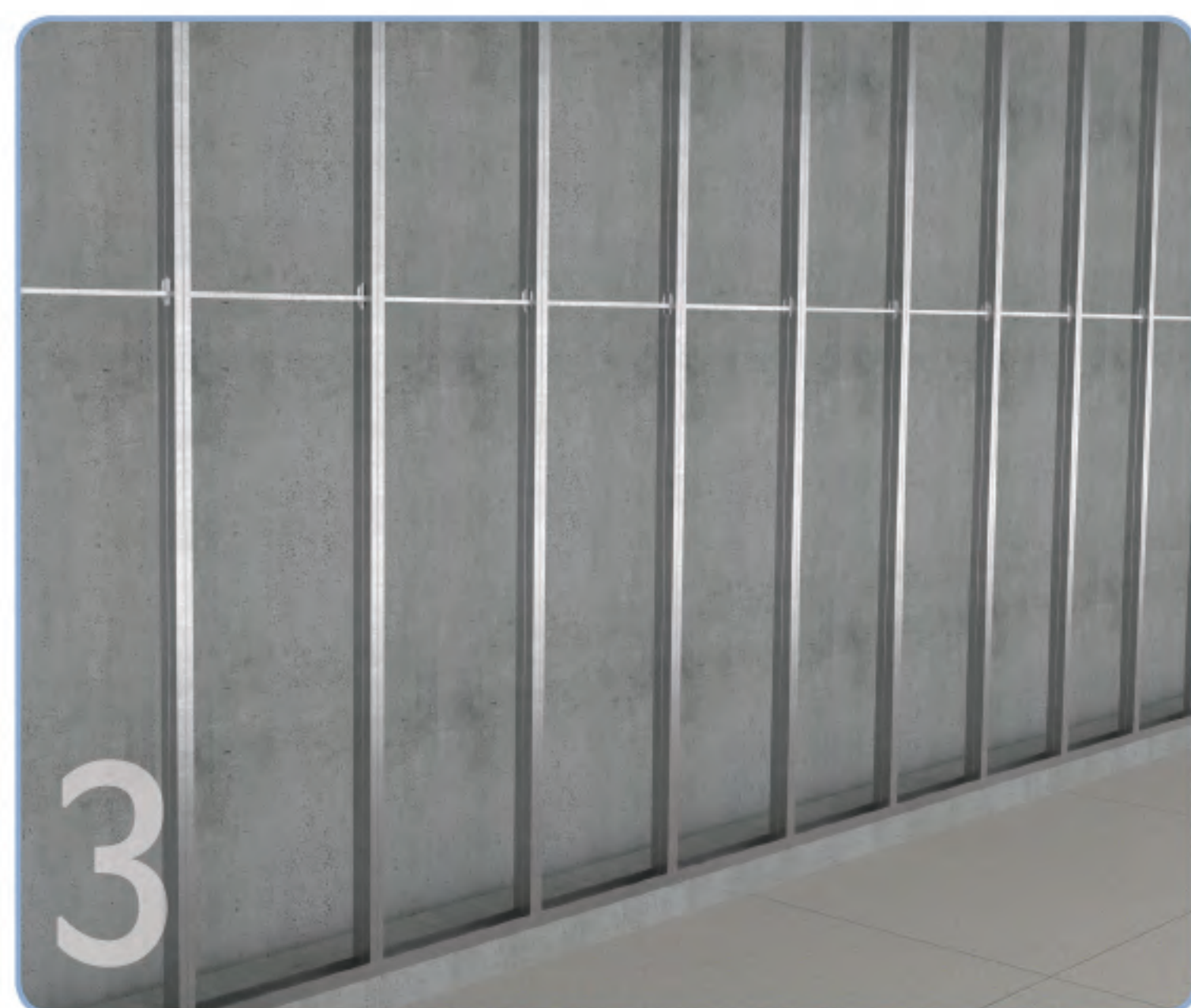
3 C-STUD에 Carrying Channel을 3,000mm이내로 수평 설치한다
