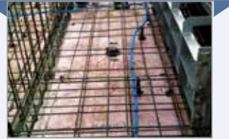
③ 철근 배근 및 콘크리트 타설
