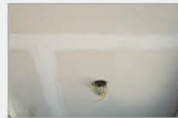
⑤ 퍼티 작업 이음매 및 파손부위를 퍼티 작업합니다.
