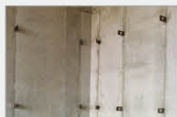
① 바탕벽 정리하기 콘크리트 웅벽을 깨끗하게 정리합니다.
