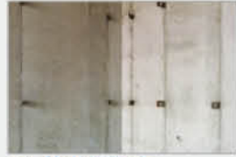
① 바탕벽 정리하기 콘크리트 웅벽을 깨끗하게 정리합니다.
