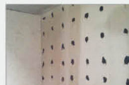
② 본드 칠하기 바탕벽에 G2 또는 석고본드를 30cm 간격, 소오두께(5mm)의 3배, 직경 50mm 정도로 바릅니다.
